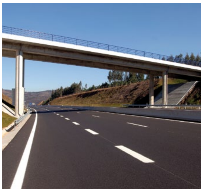
Auto-Estrada, A28 A28 Highway / Autoroute A28 Portugal
