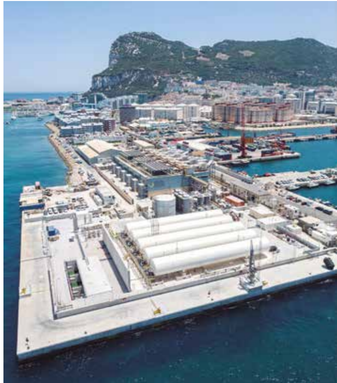
↑ LNG Terminal GPL Gibraltar
